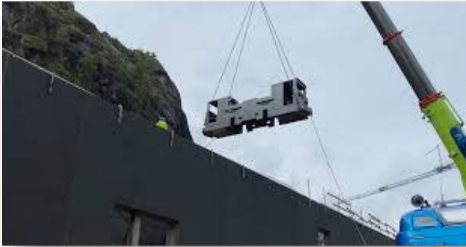
Et tog på 12 tonn, som har vært i bruk i gruven i Sandbekk, heises på plass FØR taket lagges på. Toget skal stå i VELKOMST-rommet
